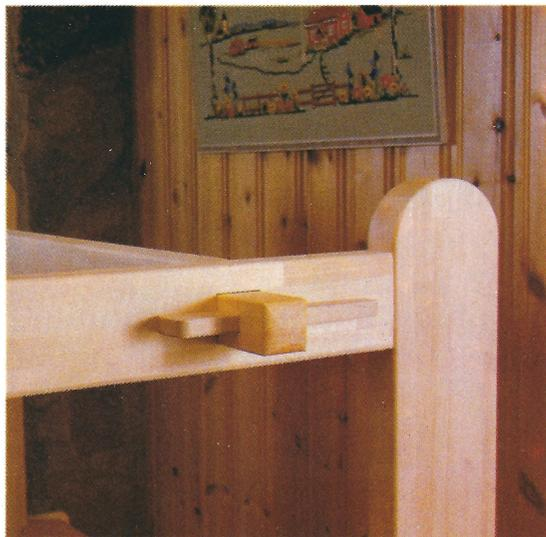
Der Webstuhl wird, wie seit Jahrhunderten, mit Keilen zusammengesetzt. Das macht ihn stabil, leicht montierbar und demontierbar.
